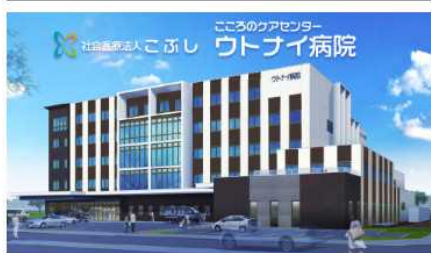
2023年10月完成予定 オープンに向け建設中です。
