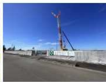
6月 基礎工事開始
