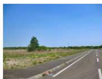
5月 工事着工前
