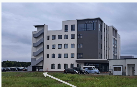
ウトナイ病院北側 屋内階段入口
